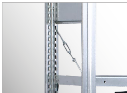
Kreuzdiagonale als Feldaussteifung
